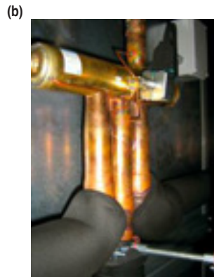
Valvole di espansione termostatica (a); valvola di inversione a 4 vie (b); filtro deidratatore (c). Thermostatic expansion valve (a); 4-way reversing valve (b); dryer filter (c)
