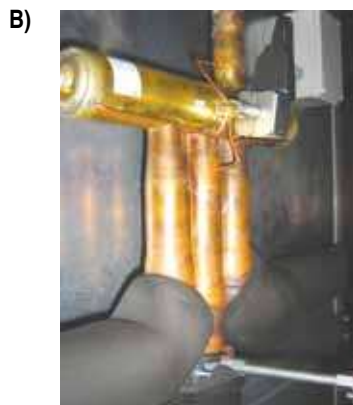
Valvole di espansione termostatica (a); valvola di inversione a 4 vie (b); filtro deidratatore (c). Thermostatic expansion valve (a); 4-way reversing valve (b); dryer filter (c)
