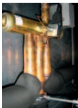
Fig. b - Valvola di inversione a 4 vie 4-way reversing valve
