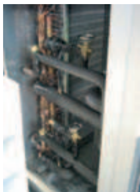
Fig. a - Valvole di espansione termostatica Thermostatic expansion valve
