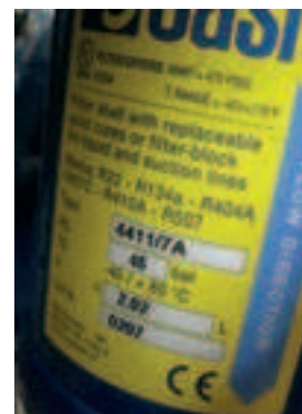
Fig. c - Filtro deidratatore Dryer filter
